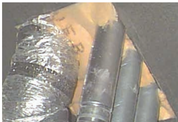
Minerale wol alleen is geen luchtdichting!
